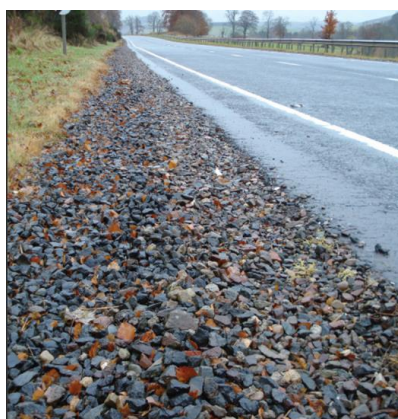
Figura 19. Sinistra: esempio di trincea infiltrante (Woods Ballard et al. 2015. “The Suds Manual”). Destra: Tipologico trincea infiltrante (Linee guida sull’adozione di tecniche di drenaggio urbano sostenibile per una città più resiliente ai cambiamenti climatici del Comune di Bologna, 2018)
