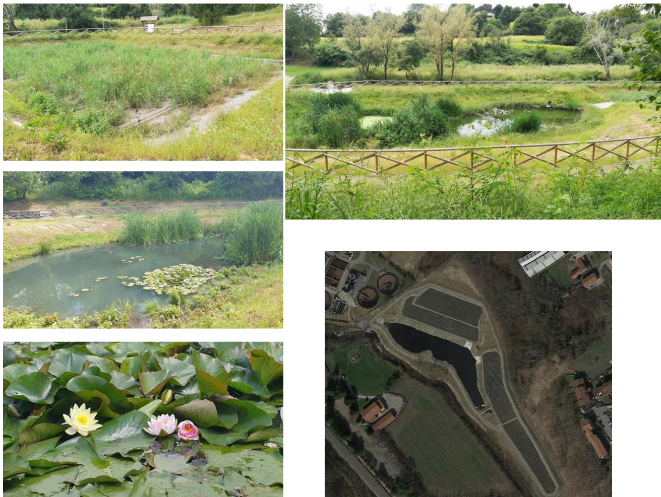
Figura 27. Impianti di fitodepurazione per sfiori da fognatura mista progettati da IRIDRA Srl in Regione Lombardia (Villaguardia, Capiago, Carimate).
