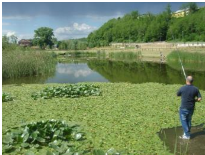
Figura 25. Sistema di fitodepurazione per sfioro fognario realizzato a Gorla Maggiore (VA), monitorato nell'ambito del progetto EU OpenNESS – Fonte Iridra Srl
