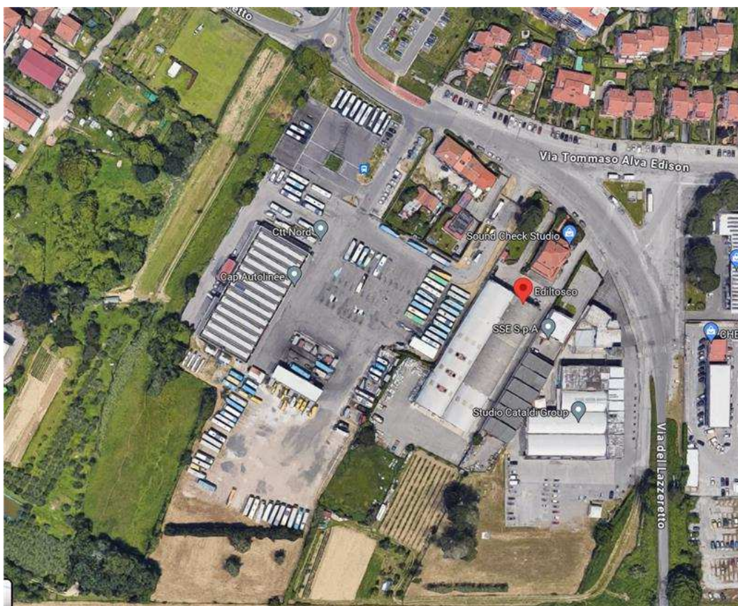
Figura 26- Deposito Autolinee Toscane in via del Lazzaretto 70
