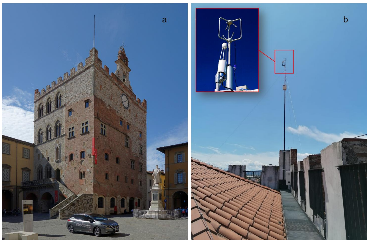
879 880 Figura 41. Installazione della stazione Eddy Covariance su Palazzo Pretorio (a) nel centro della città di Prato. A destra 881 (b) dettaglio della strumentazione utilizzata comprensiva di analizzatore di gas ad infrarosso e anemometro triassiale.
