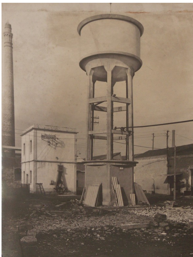
Deposito aereo in cemento armato appena realizzato
