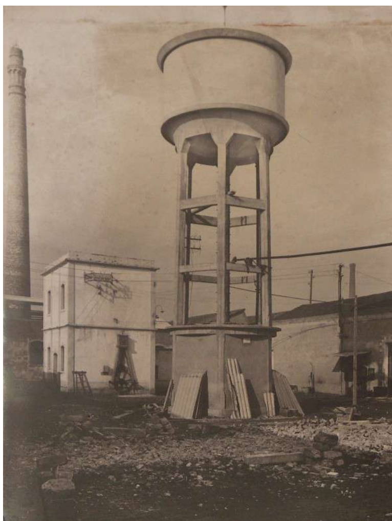
Deposito aereo in cemento armato appena realizzato
