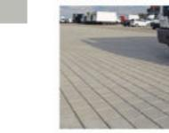
costituiti da blocchi di calcestruzzo o altri materiali resistenti progettati per avere delle sporgenze e incavi che si incastriano fra loro. Si caratterizzano per la resistenza elevata, facilità di installazione e manutenzione, nonché per la loro capacità di sopportare carichi pesanti e di resistere all'usura causata dal traffico veicolare.
