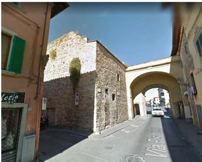
Edificio addossato alla Porta Pistoiese
