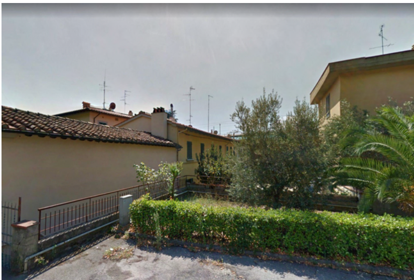
Edificio in via Firenze 34
