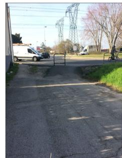
Sistemazione dell'accesso con riduzione della pendenza e sistemazione superficiale. In funzione della quantità di materiale necessario, verrà usato un sottofondo tipo misto cementato e/o asfalto o secondo le indicazioni del comune.
